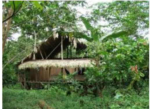
Gästehaus, das durch das Unwetter zerstört wurde. Foto: K. Ludwiga
